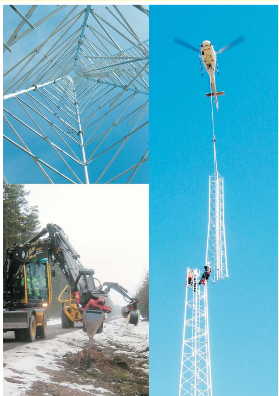
Bredbandsutbyggnad etapp 2. Grävning för fiber till Rejmyre och resning av masten i Igelfors
